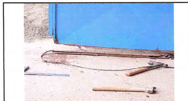
Foto 4: Corte, lijado y pintado de puertas.
