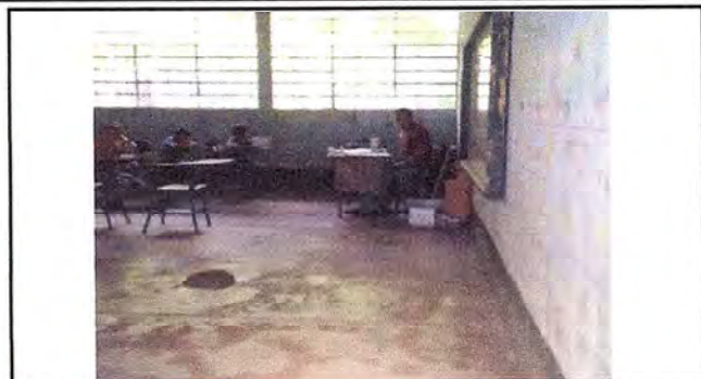
Foto 2: Reparación de techo, para evitar el acumulamiento de agua dentro del aula.
