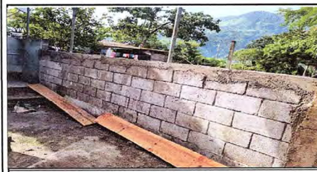
Foto 5: Fundición de soleras para el mejor soporte a la estructura del muro perimetral.
