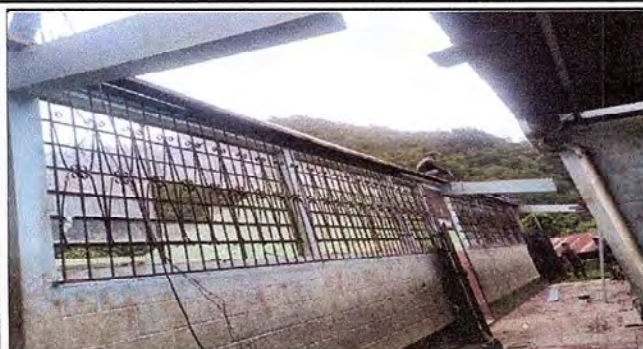
Foto 1: Desmantelamiento de estructura metálica y laminas del modulo intervenido.
