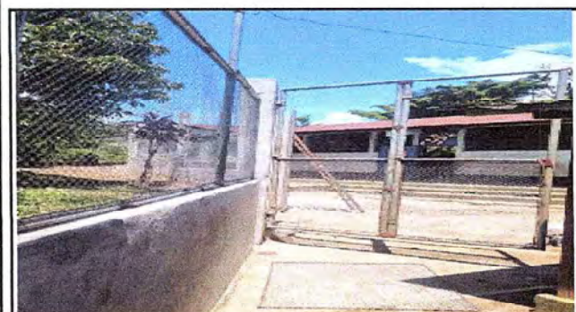
Foto 3: Extracción de malla y soldadura del porton
