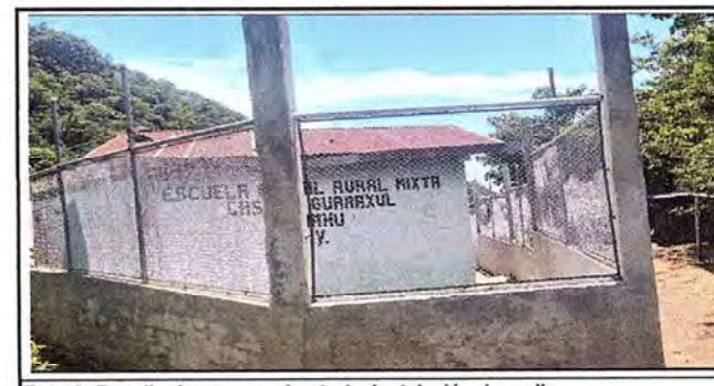
Foto 6: Repello de muro perimetral e instalación de malla.
